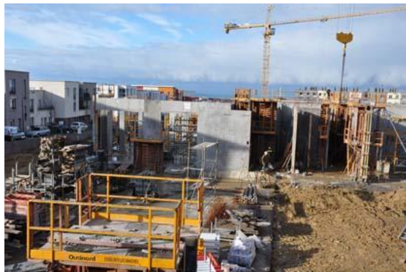
Travaux sur le Projet de rénovation urbaine du Chemin vert à Boulogne sur Mer
