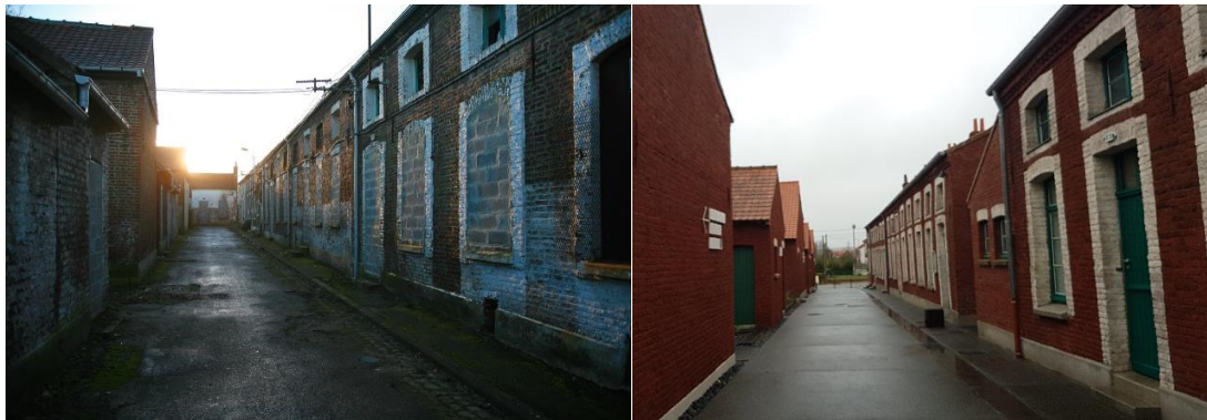
Figure 13 : la cité des électriciens Bruay la Buissière, "d'hier à demain", https://www.citedeselectriciens.fr/fr/la-cite/dhier-demain
