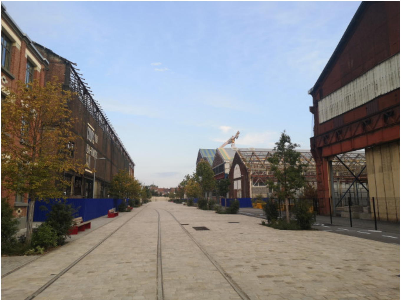
Cours Jean-François Cail - Réhabilitation des Halles de Fives Cail
