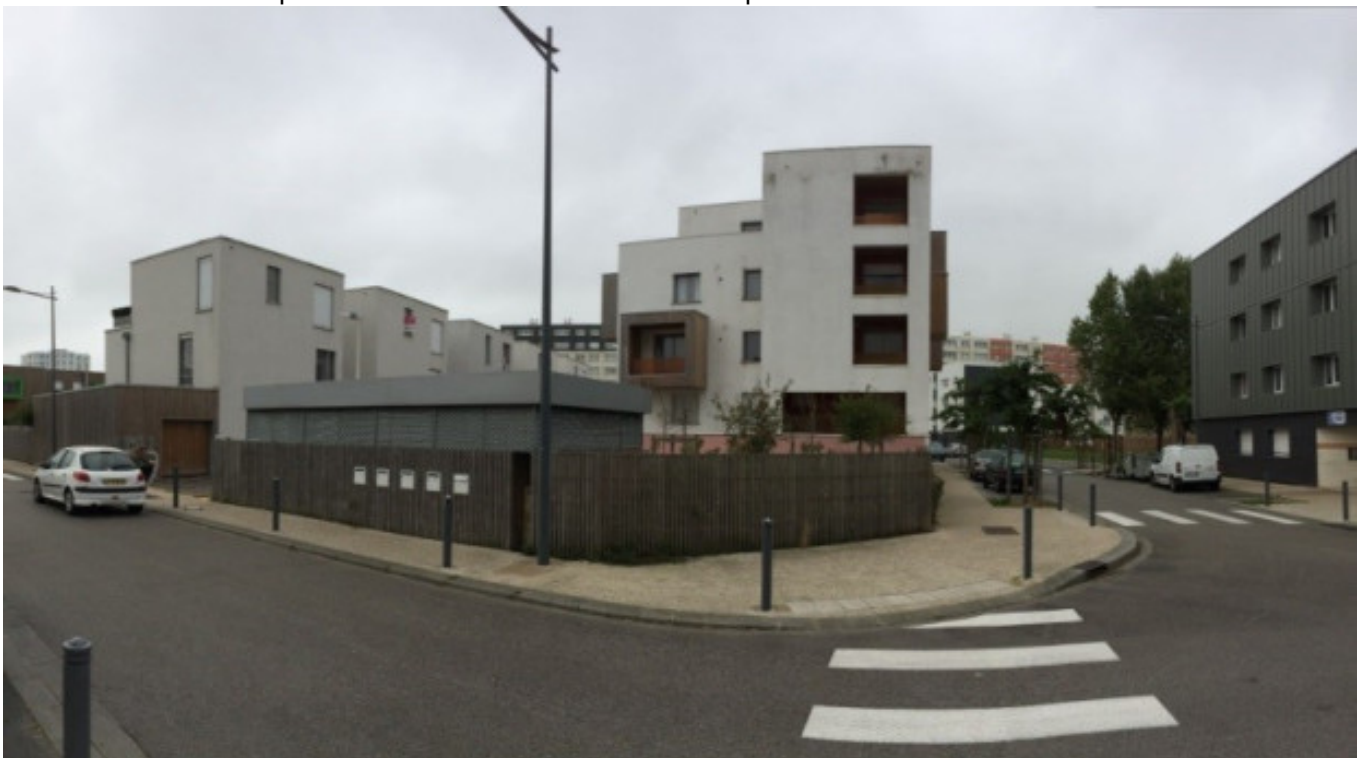
Figure 1 : logement en accession pour permettre l'arrivée de nouvelles populations dans le quartier du Beau Marais
